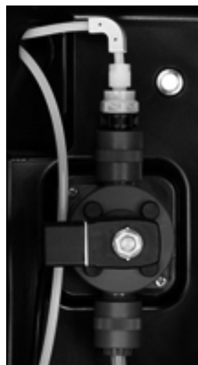
Abb. 40 Magnetventil (OCD-162-5)
